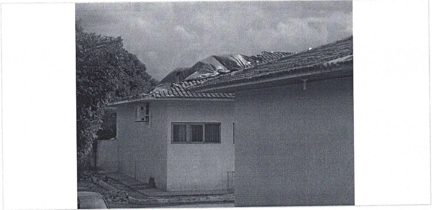
Fotografia da 1ª etapa de execução Data da última atualização: 29/04/2016
