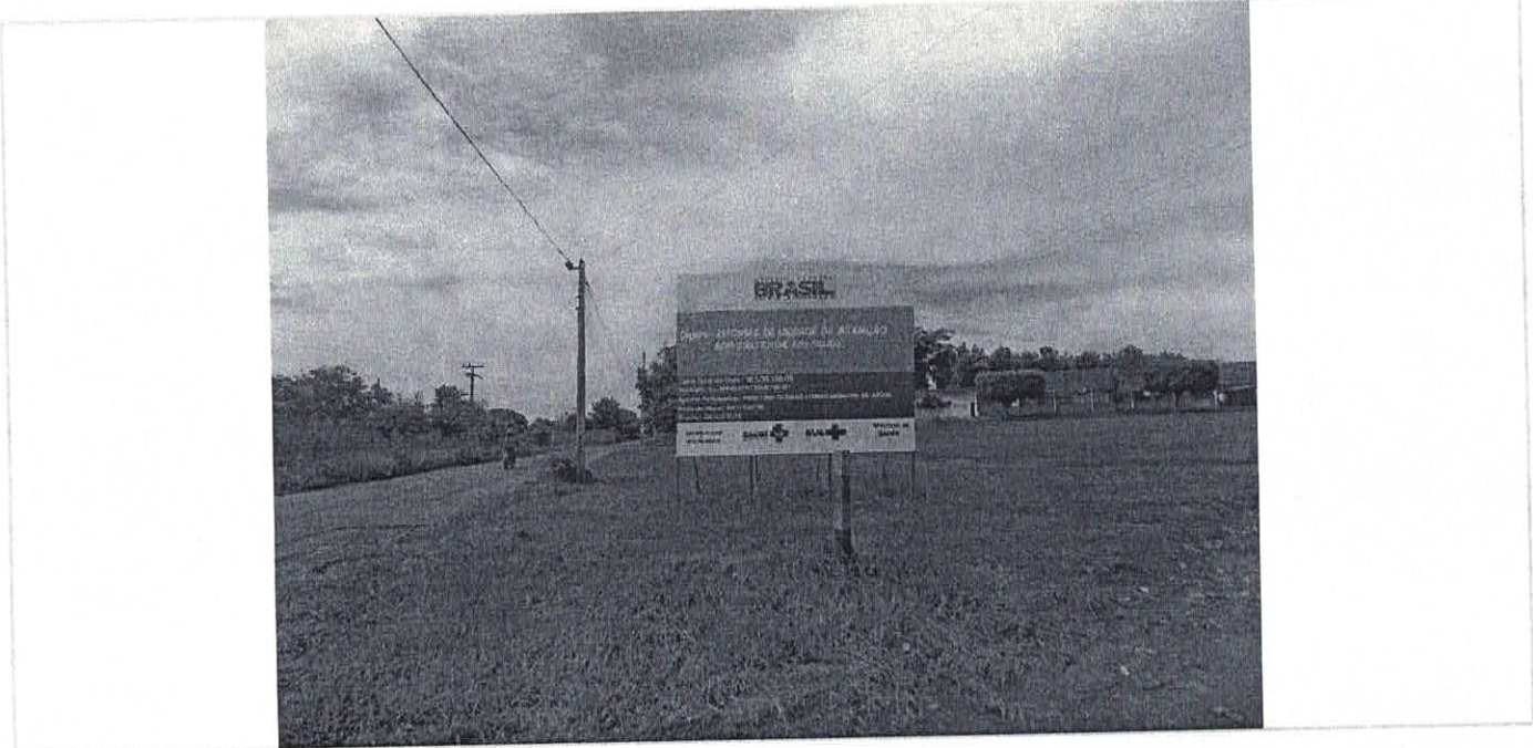
Placa da obra Data da última atualização: 29/04/2016
